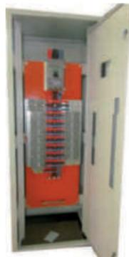
Tablero de distribución tipo panel board, grado de protección IP 54, color RAL 7032, mandil abisagrado, uso interior.
